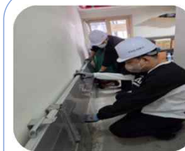
(장애인회관) 차수판 설치 점검
