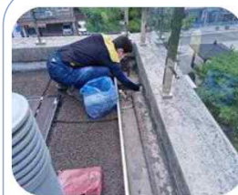
(송내어울마당) 배수구 및 배수로 점검
