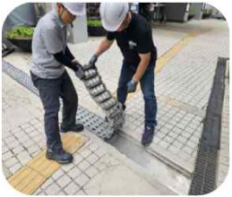
(복사골문화센터) 배수로 준설
