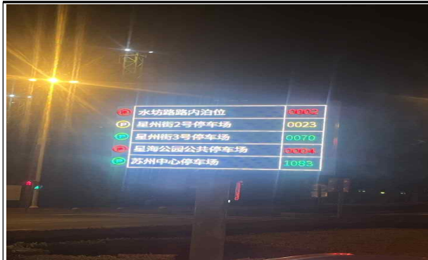
VMS, 주차장 잔여면수 및 위치 송출
